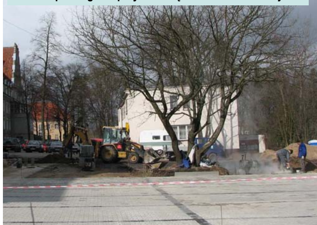
Budowa parkingu za przychodnią na ul. Królewieckiej
