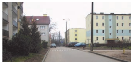
Odremonтовana droga wewnętrzna na osiedlu przy ul. Młynowej
