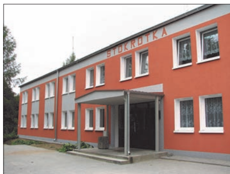
Przedszkole „Stokrotka” po zakończonej Termomodernizacji. Fot. Natalia Koptas
