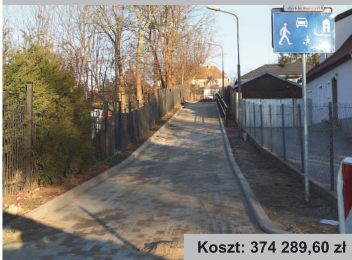
Przebudowa drogi w ul. Ogrodowej
