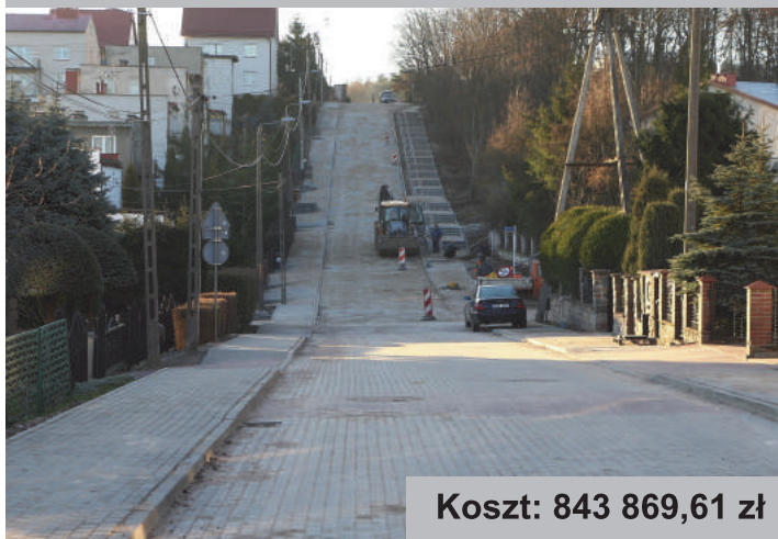
Przebudowa drogi ul. Widok wraz z infrastrukturą techniczną
