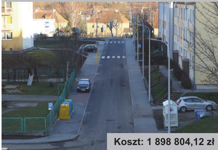
Przebudowa dróg w ul. Sienkiewicza i Plutonowej wraz z infrastrukturą techniczną
