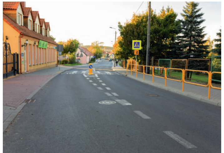
Przebudowa ulicy Bohaterów Warszawy wraz z infrastrukturą techniczną
