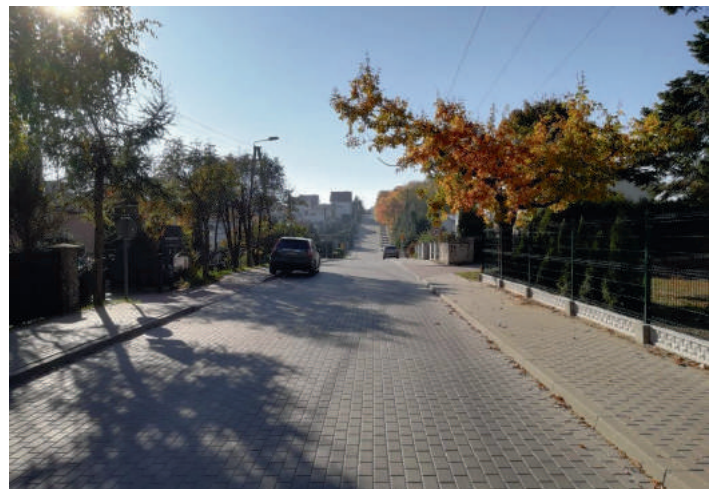
Przebudowa ul. Widok
