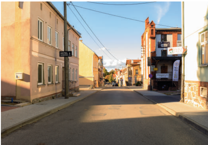
Zmodernizowanie ulicy i chodników na ul. Roosevelta
