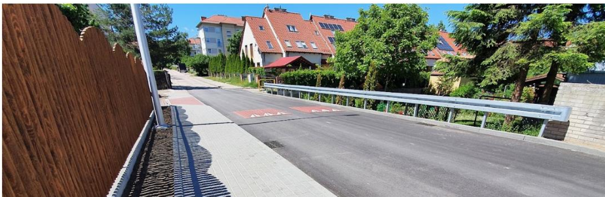
Wyremontowana ul. Żołnierska w Mrągowie
