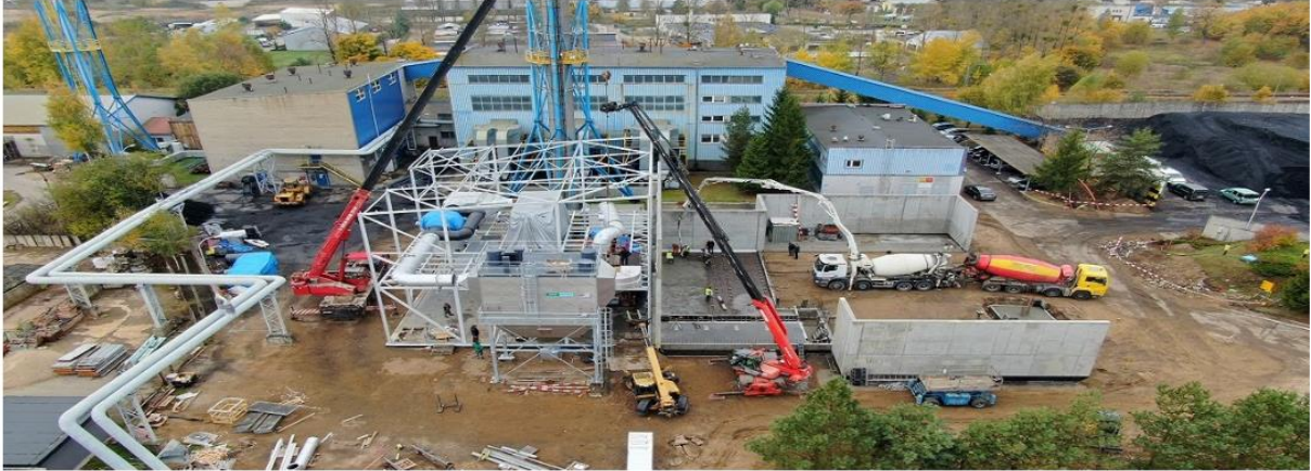
Modernizacja kotłowni rejonowej MEC Sp. z o.o. w Mrągowie- budowa kotłowni bazującej na produkcji energii cieplnej ze spalania biomasy
