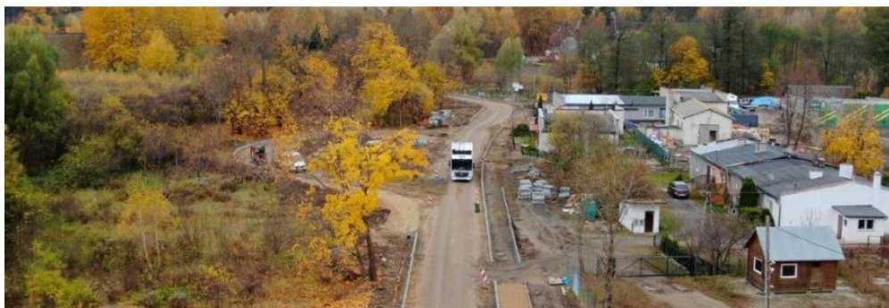
Przebudowa ulicy Krótkiej
