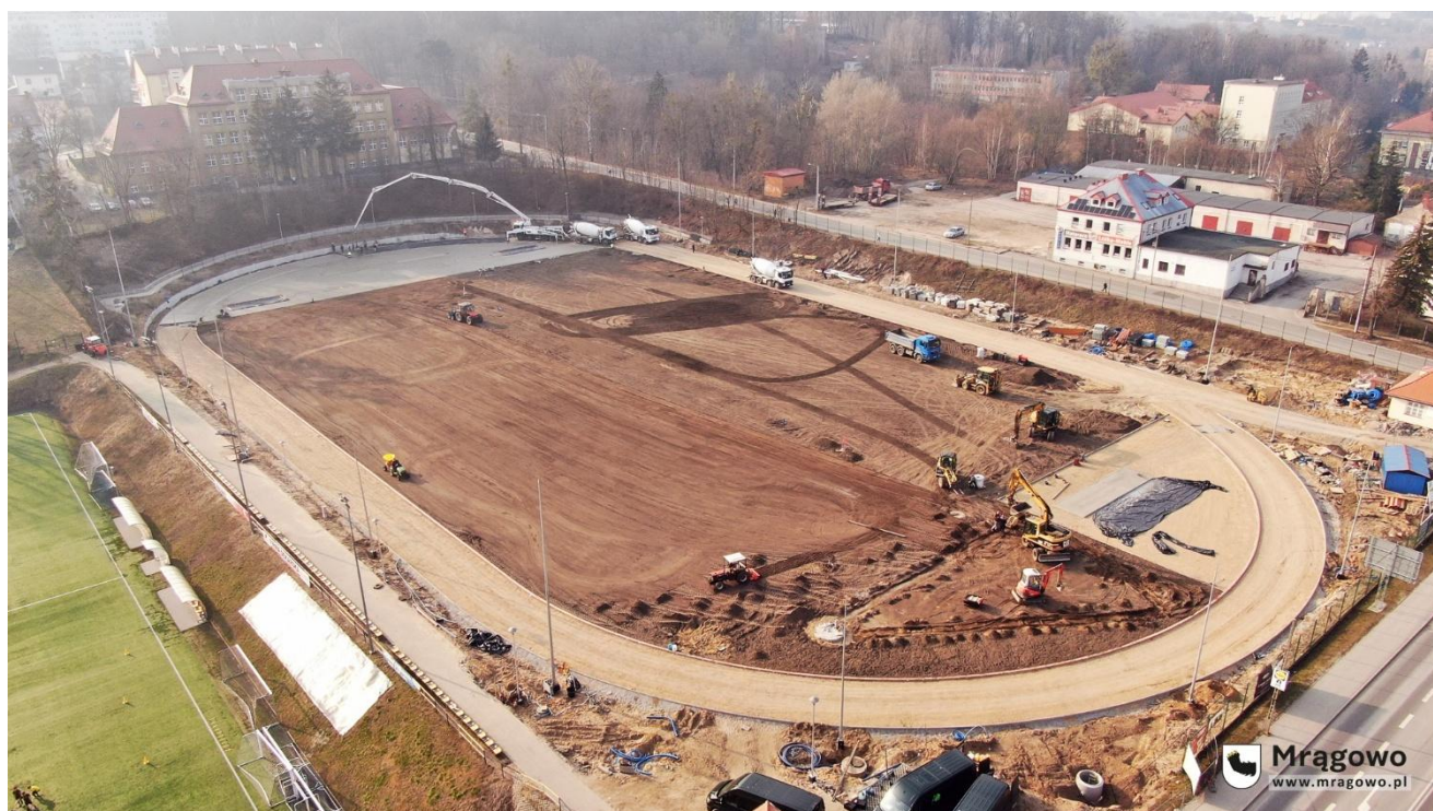
6. Przebudowa stadionu miejskiego
