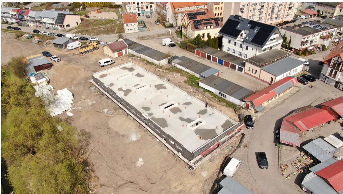
5. Remont budynku szkolnego wraz z elementami zagospodarowania terenu Szkoły Podstawowej Nr 1 przy ul. Bohaterów Warszawy w Mrągowie
